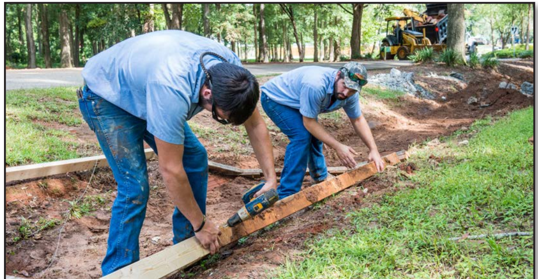
Avondale Subdivision culvert work
