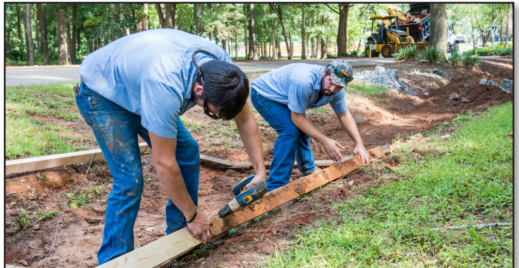
Avondale Subdivision culvert work
