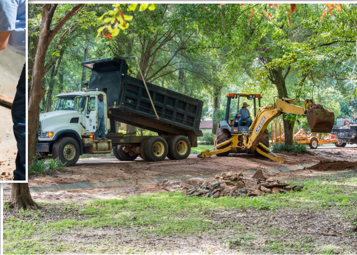
Avondale Subdivision culvert work
